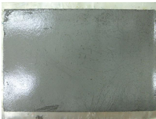
写真2 モルタル下地
