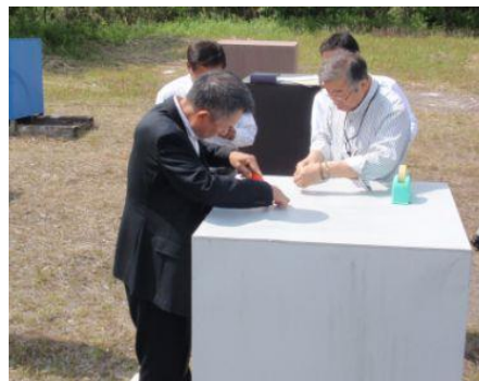
写真6 付着試験を実施中
