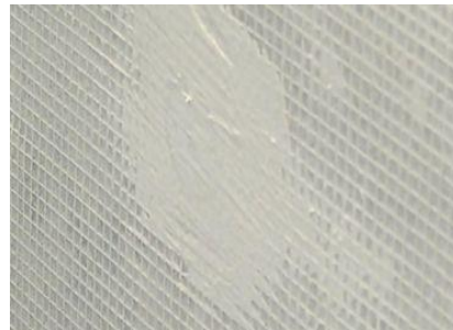
写真6 ピン頭部処理
